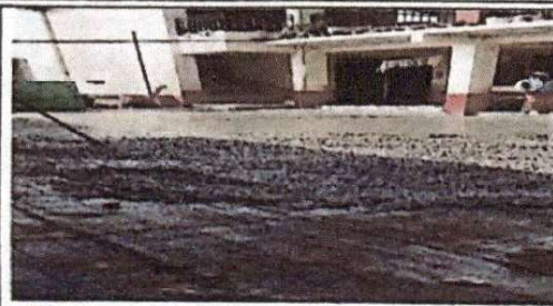
Foto 1: vaciado de concreto osa de patio
