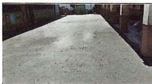
Foto 4: osa de patio terminada
