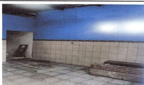
Foto 2: Reparación de Polletón
