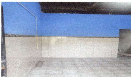
Foto 3: Instalación de azulejo en cocina
