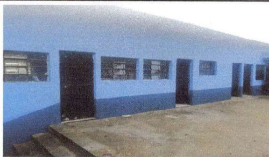
Foto1: Pintura de paredes
