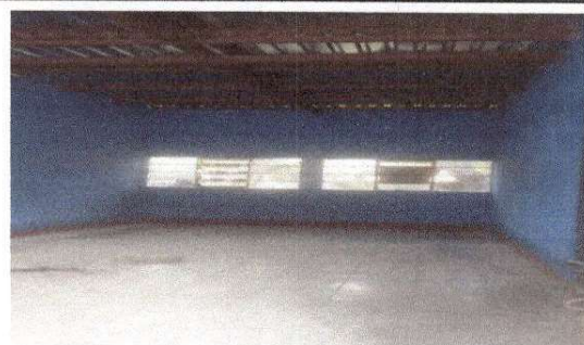
Foto 6: Estructura del techo
