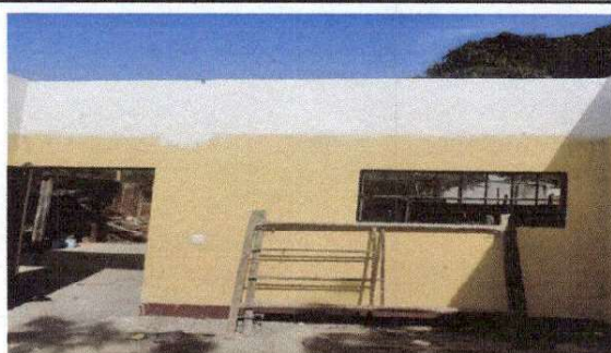
Foto 2: Aplicación de cernido en bodega
