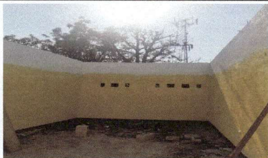
Foto 3: Aplicación de cernido en bodega
