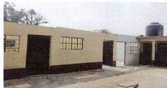
Foto 6: Desmontaje de estructura de techo
