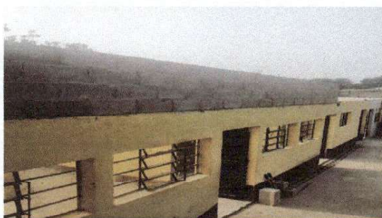
Foto 5: Levantamiento frontal de pared
