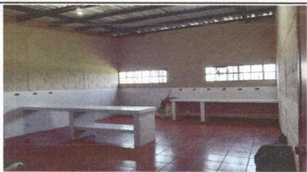
Foto1: Cocina un 70% por terminada.
