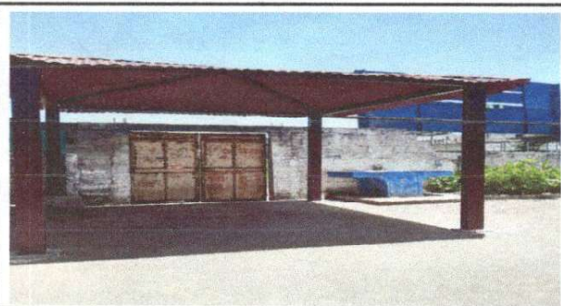
Foto 5: Area con choza terminada.
