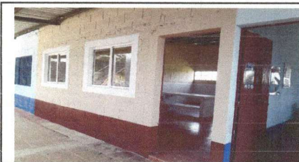
Foto 6: Exterior de cocina terminada.
