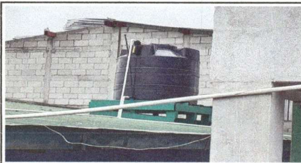
Foto 4: Tinaco ya colocado en su correspondiente lugar.
