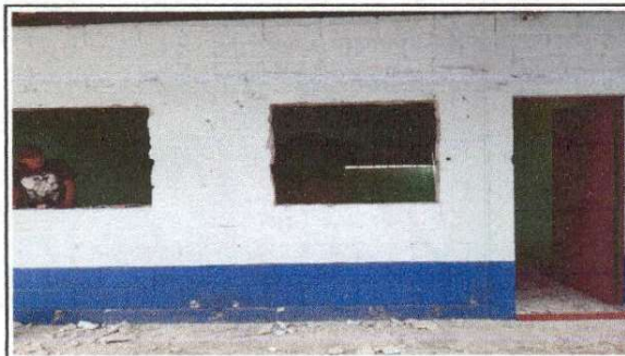
Foto 4: La parte el exterior se van a repellar las ventanas.
