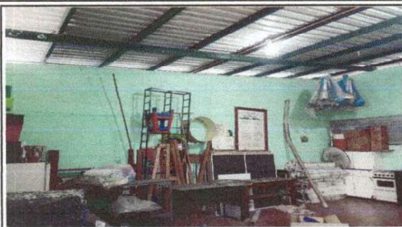
Foto1: Salon donde estan comenzando a construir la cocina.
