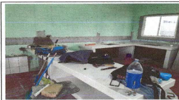
Foto 3: Islas casi por terminadas de la cocina.
