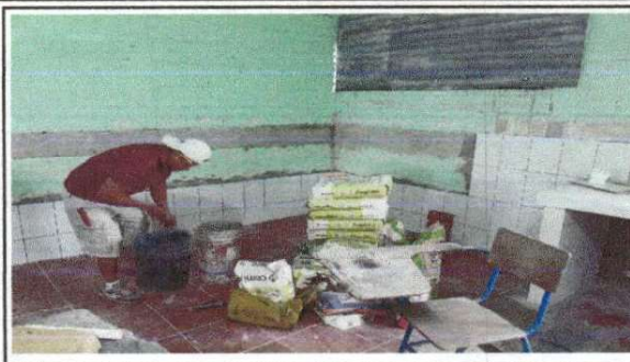
Foto 2: Se les esta colocando el azulejo para la isla de la cocina.
