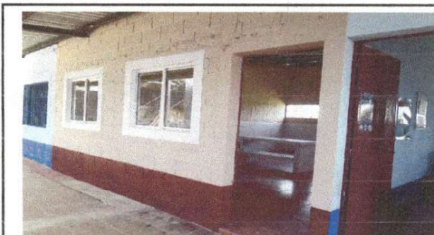
Foto 6: Exterior de cocina terminada.
