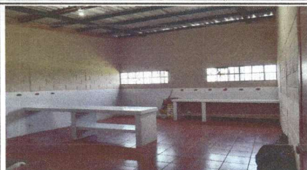
Foto1: Cocina un 70% por terminada.
