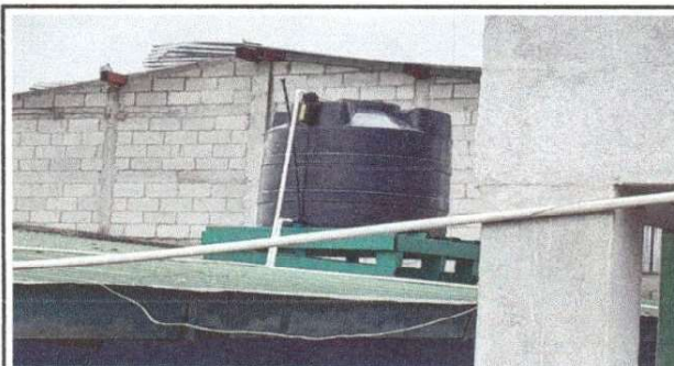
Foto 4: Tinaco ya colocado en su correspondiente lugar.
