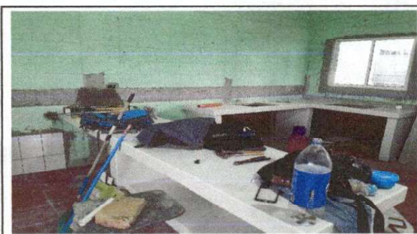
Foto 3: Islas casi por terminadas de la cocina.
