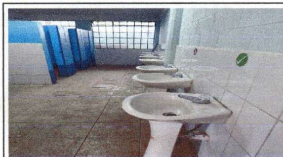
Foto 6: Se cambiaron las llaves de los chorros.
