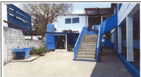
Foto 5: Area donde se va construir una choza.
