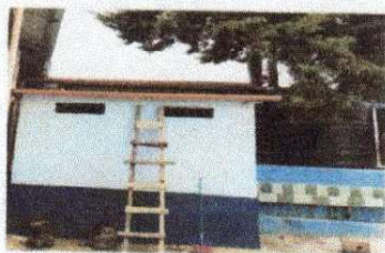
Foto 5: pintura y azulejado de exteriores
