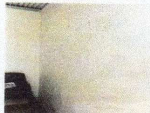
Foto 4: repello y cernido de paredes.
