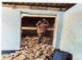
Foto 1: ampliación de cocina
