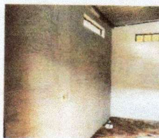
Foto 6: repello y cernido de paredes
