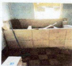
Foto 5: colocación de pila de concreto
