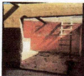
Foto 2: sustitución de techo y levantamiento de solera.
