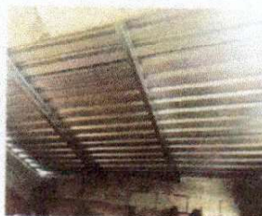
Foto 4: sustitución de techo
