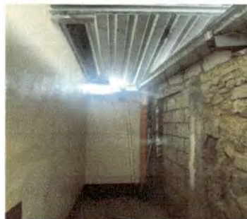
Foto 8: levantamiento de muro interno
