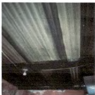
Foto7: Sustitución de techo de madera por costaneras
