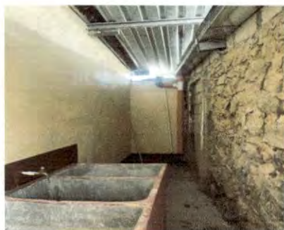
Foto 5: levantamiento de muro para union,
