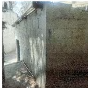
Foto 16: mejoramiento de paredes
