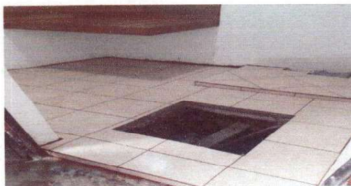
Foto 5: Sustitución de piso de torta de concreto
