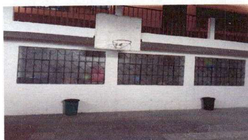
Foto 4: Aplicación de sabieta
