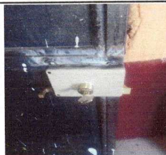
Foto 6: mantenimiento de estructura de metal
