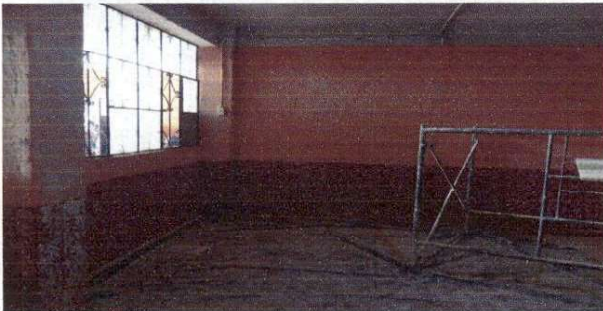
Foto 3: Cernido paredes de dirección
