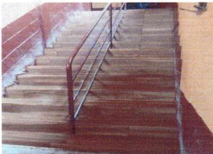
Foto 5: Sustitución de piso de torta de concreto
