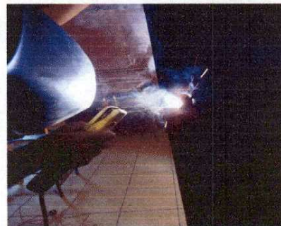
Foto 6: mantenimiento de estructura de metal
