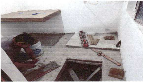
Foto1: Cernido de paredes de bodega de cocina
