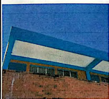
Foto 3: Se reparó de losa del segundo nivel debido a filtraciones de agua aplicando hilera de block y pintando la losa.
