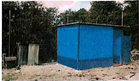
Foto 8: Aplicación de cernido y pintura en paredes exteriores de cocina.
