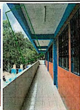
Foto 3: Se reparó de losa del segundo nivel debido a filtraciones de agua aplicando hilera de block y pintando la losa.
