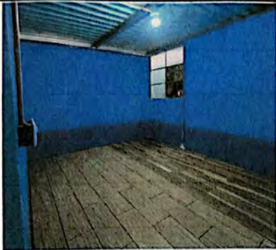
Foto 7: Aplicación de cernido y pintura en paredes de cocina. Sustitución de torta de concreto por piso.
