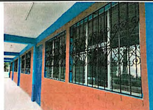
Foto 6: Instalación de balcones en todas las ventanas del segundo nivel finalizado.
