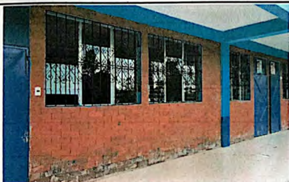
Foto 5: Instalación de balcones en todas las ventanas del primer nivel finalizado.
