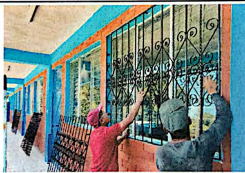
Foto 6: Colocación de balcones en todas las ventanas del primer nivel para mayor seguridad debido a la falta de muro perimetral en el establecimiento.
