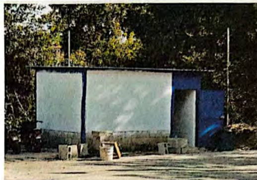
Foto 8: Aplicación de cernido en paredes en exteriores de cocina.
