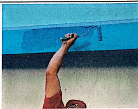
Foto 4: Reparación de losa del segundo nivel para evitar filtraciones de agua aplicando encima una hilera de block y pintura sobre la losa.
