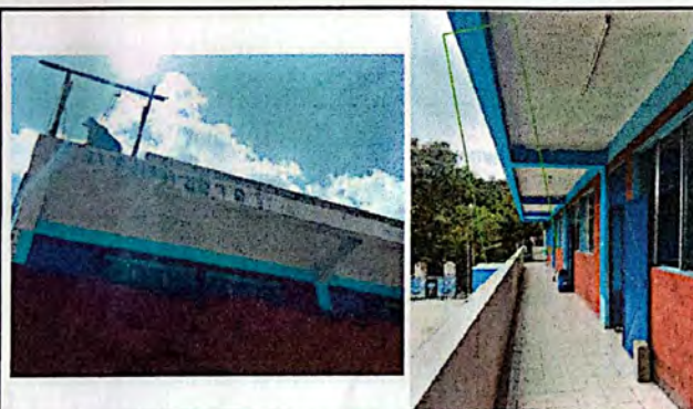
Foto 3: Reparación de losa del segundo nivel para evitar filtraciones de agua, aplicando encima una hilera de block y pintura sobre la losa.
