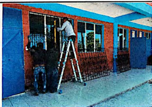
Foto 5: Colocación de balcones en todas las ventanas del primer nivel para mayor seguridad debido a la falta de muro perimetral en el establecimiento.
