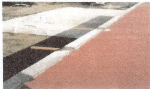
Foto 6: Módulo No. 1: Mantenimiento de agua pluvial.
