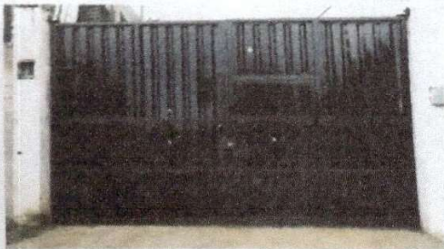
Foto 5: Módulo No. 1: Mantenimiento de portón.
