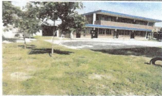
Foto 3: Módulo No. 1: Pintura de exterior e interior.
