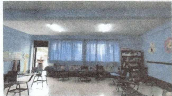
Foto 4: Módulo No. 1: Pintura en el interior de las aulas.
