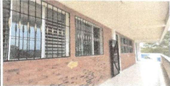
Foto 2: Módulo No. 1: Colocación de balcones en todas la ventanas de la escuela.
