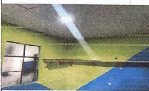
Foto 6: Finalización de proyecto, estructura de cielo falso, en dirección
