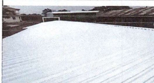
Foto 2: Finalización de proyecto estructura de lamina troquelada y calda de agua, primer nivel y segundo nivel.
