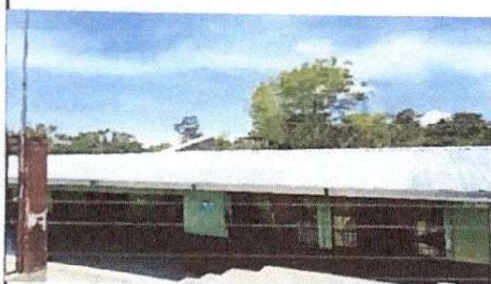
Foto 1: Finalización de proyecto estructura de lamina troquelada y calda de agua
