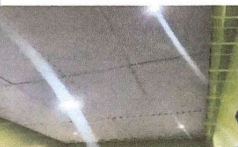
Foto 5: Finalización de proyecto, estructura de cielo falso, en dirección
