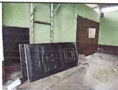
Foto 6: En proceso Cambio de porton
