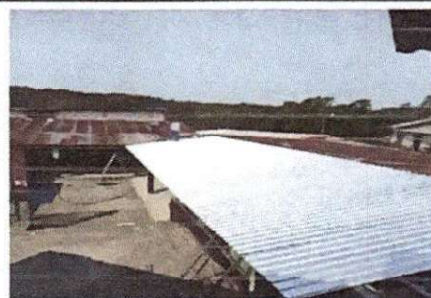
Foto 2: En proceso cambio de estructura de Techo y cubierta de lamina troquelada
