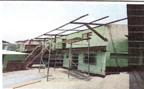
Foto 4: En proceso cambio de estructura de Techo y cubierta de lamina troquelada
