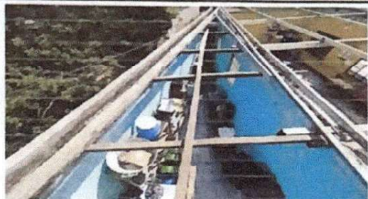
Foto 1: En proceso de cambio de estructura de Techo y cubierta de lamina troquelada
