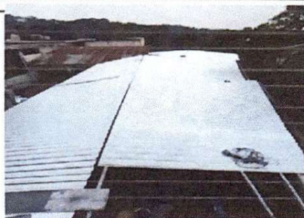
Foto 3: En proceso cambio de estructura de Techo y cubierta de lamina troquelada
