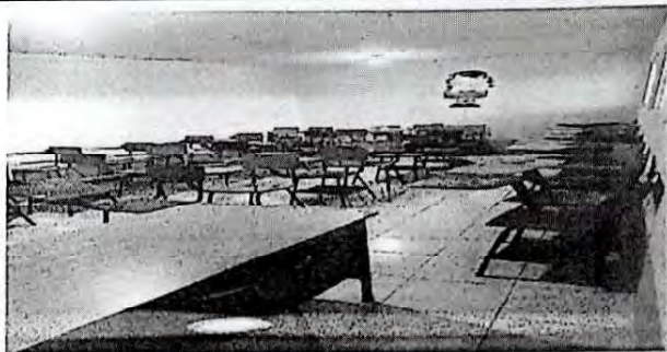
Foto 4: Salón de 1o. Básico, pintado y con piso instalado.
