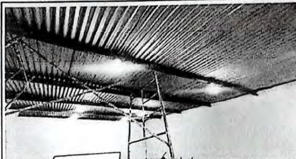
Foto 2: Iluminación, salón de 3o. Básico.
