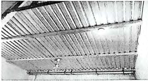
Foto 1: Techo nuevo en salón de Dirección.
