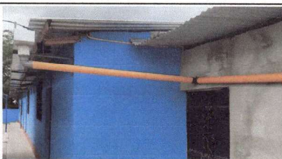
Foto 5: Finalizado trabajo de instalación de canales.
