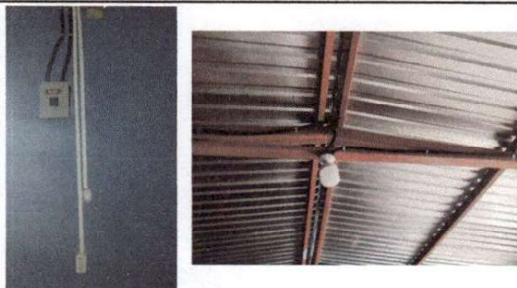
Foto 3: Finalizado trabajo de instalación eléctrica en 4 aulas y exterior.
