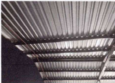
Foto 1: Finalizado trabajo de instalación de lámina troquelada en cocina.
