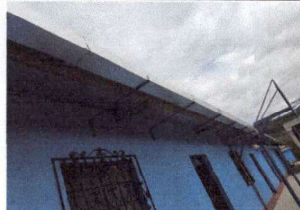
Foto 6: Finalizado trabajo de instalación de canales.
