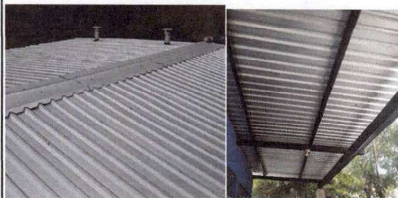
Foto 2: Finalizado trabajo de instalación de lámina troquelada en cocina.
