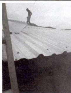
Foto 2: instalando lámina troquelada en la cocina.
