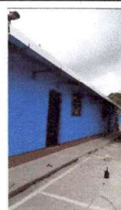
Foto 6: instalación de canales.
