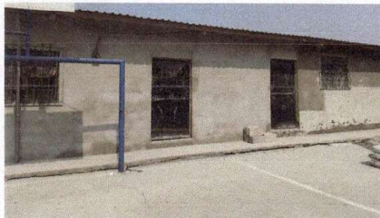
Foto 3: Aplicación de nuevo repello en la pared del frente del establecimiento.
