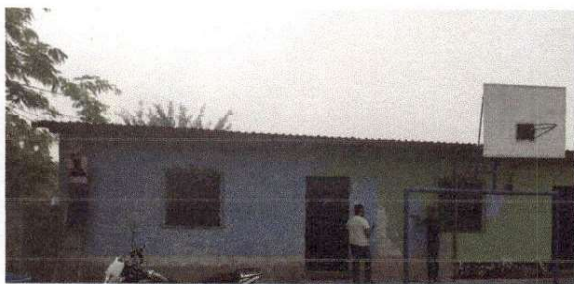
Foto 1: Retirando el repello de la pared de la parte del frente del establecimiento que se encuentra en mal estado.
