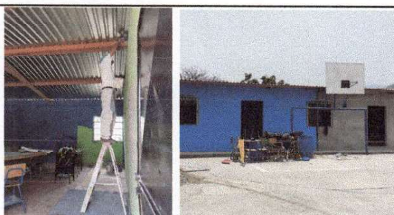
Foto 5: Aplicación de pintura en interiores y exteriores.
