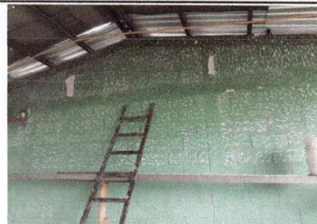
Foto 2: preparación de la pared de la cocina para la aplicación de repello.
