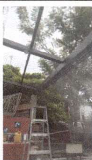
Foto1: instalando lámina troquelada y cubriendo con pintura las costaneras en la cocina.
