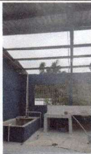
Foto1: instalando lámina troquelada y cubriendo con pintura las costaneras en la cocina.
