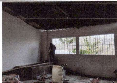
Foto 4: aplicación del repello en las paredes de la cocina.
