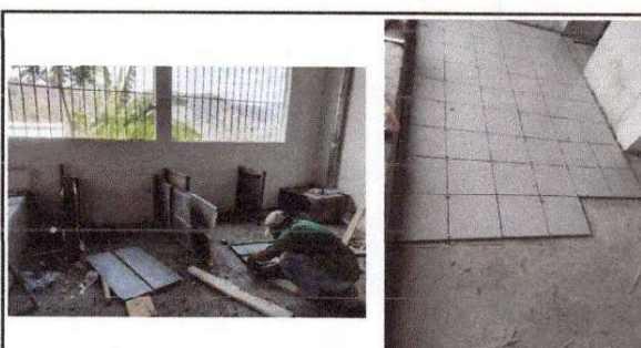
Foto 6: preparación de las bases para colocar el lavatrastos y mesa de concreto. Instalación de piso cerámico en interior y exterior de cocina.
