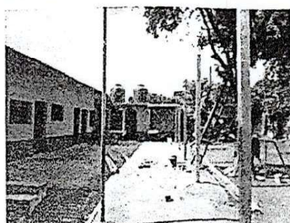
Foto 2: Proceso de Instalacion de estructura metalida que servira como domo en el Area de Pateo realizado unicamente con el Remozamiento de INEB de Telesecundaria.
