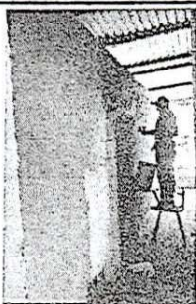
Foto 3: Proceso de Remodelacion de la entrada del Area de Cocina.
