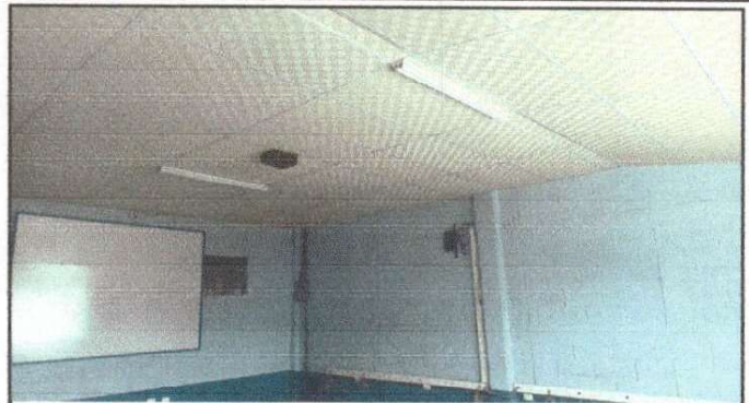
Salón donde se instaló cielo falso para disminuir el calor.
