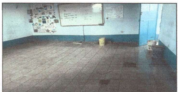
Salón donde se colocó piso cerámico.
