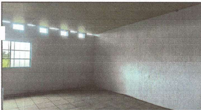
Salón donde se instaló cielo falso para disminuir el exceso de calor.
