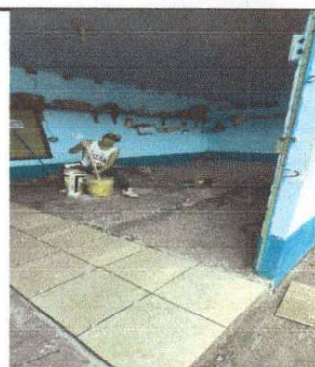
Salón donde se está instalación piso ceramico.
