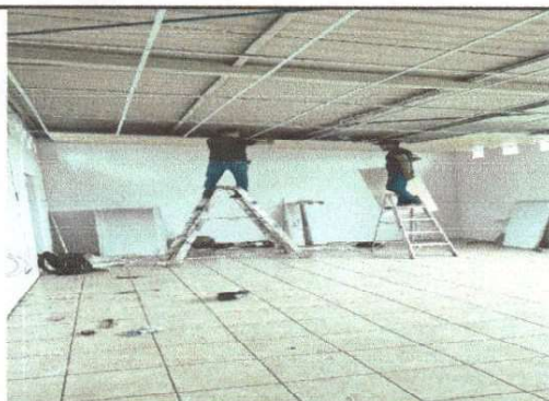
Salón donde se esta instalando cielo falso debido al calor.
