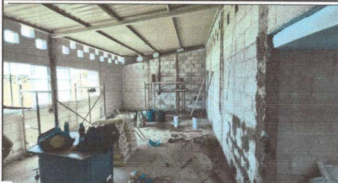
Preparando el salón con el cernido en las paredes y la base para piso ceramico.
