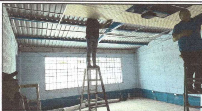
Salón de computacion donde se esta instalando cielo falso debido a que el techo esta muy bajo y hace mucho calor.
