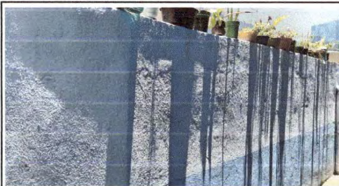
Foto 14: Muro de contención
