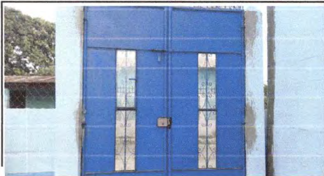
Foto 13: Reparación de portón
