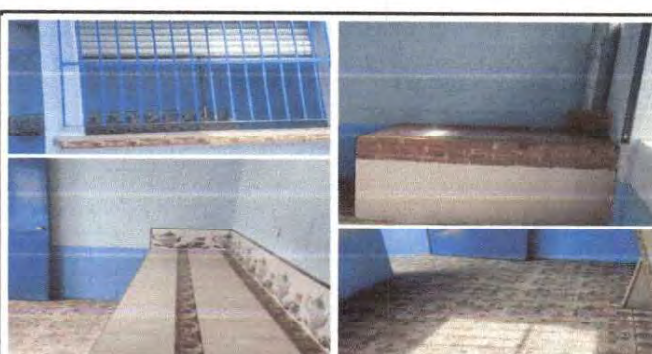
Foto 12: Reparación de cocina
