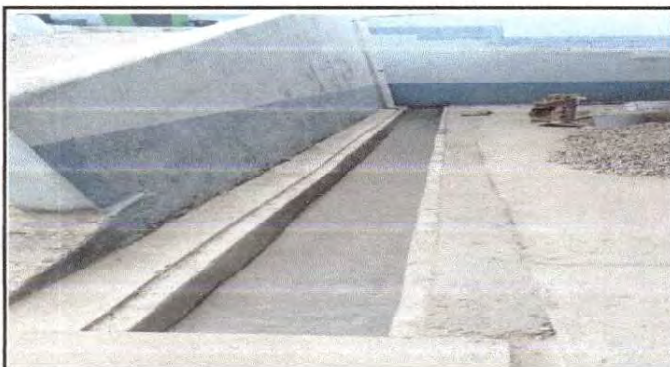
Foto 15: Cuneta de concreto
