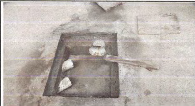
Foto 8: Reparación de drenaja
