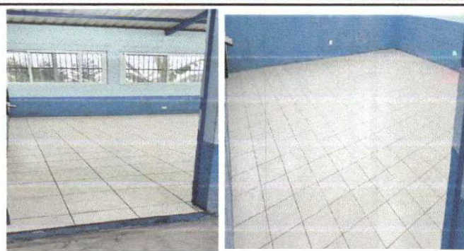
Foto 2: Sustitución de piso de granito en salones
