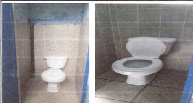
Foto7: Sustitución de accesorios (contrallave , tubo abasto)
