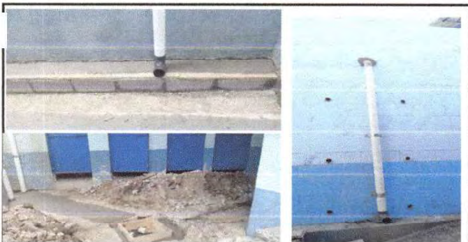
Foto 17: Reparación de Canales de agua pluvial
