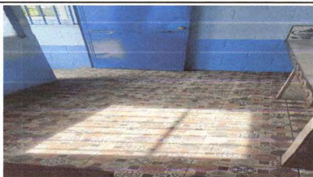
Foto 3: Sustitución de piso de granito cocina
