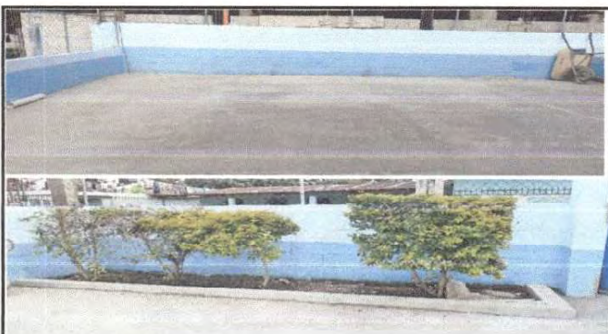
Foto 9: losa de patio
