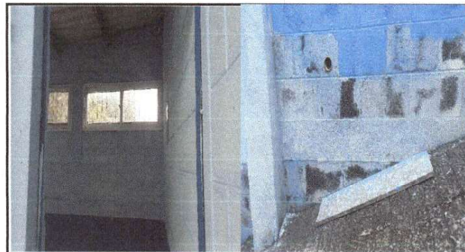
Foto 4: Pintura muros interiores
