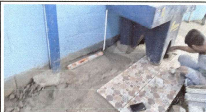
Foto 10: losa de patio
