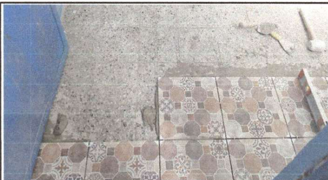
Foto 3: Sustitución de piso de granito cocina
