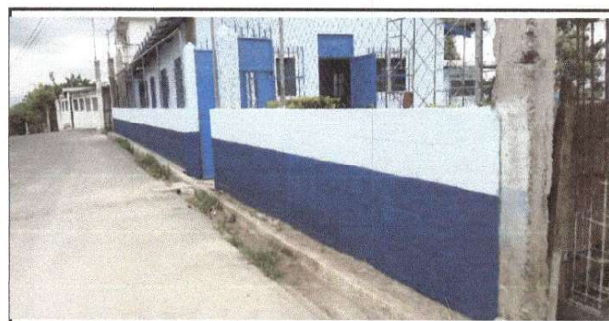
Foto 6: Pintura muros exteriores
