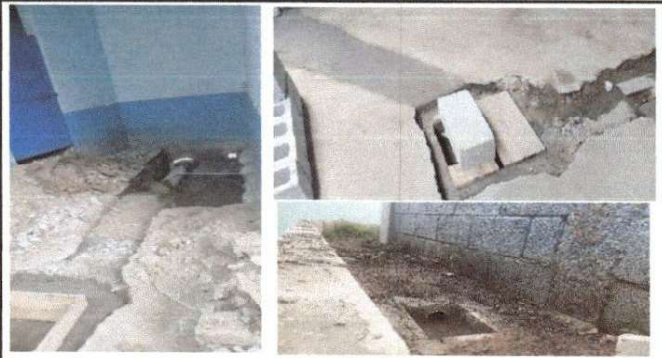
Foto 8: Reparación de drenaja
