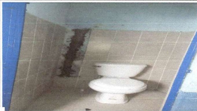
Foto 7: Sustitución de accesorios (contrallave, tubo abasto)
