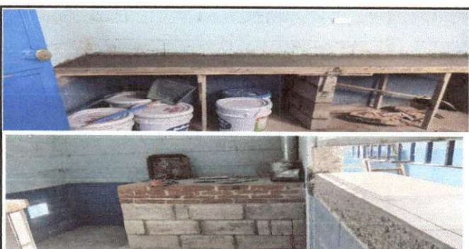
Foto 12: Reparación de cocina
