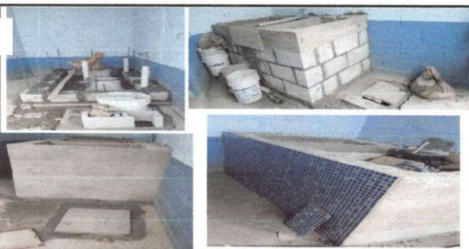
Foto 11: Pila de concreto
