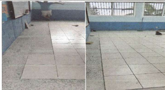
Foto 2: Sustitución de piso de granito en salones
