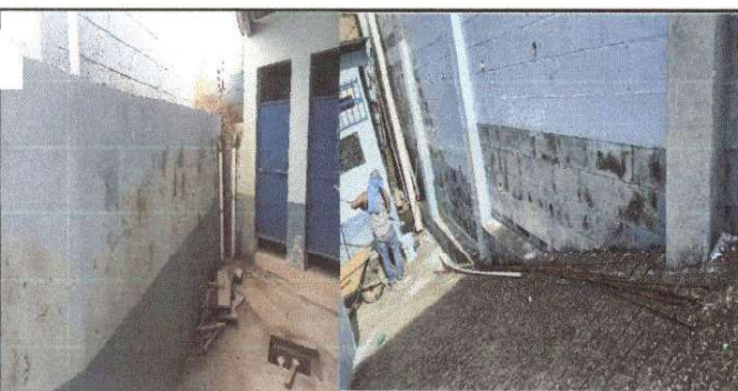
Foto 5: Pintura muros interiores
