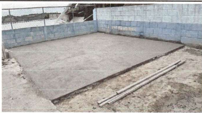
Foto 9: losa de patio
