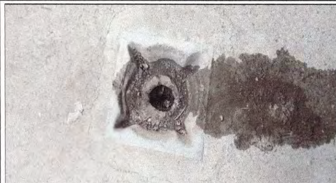
Foto 13: Reparación red de drenaje
