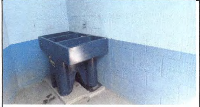
Foto 20: Sustitución de pila por pila de cemento de dos lavaderos
