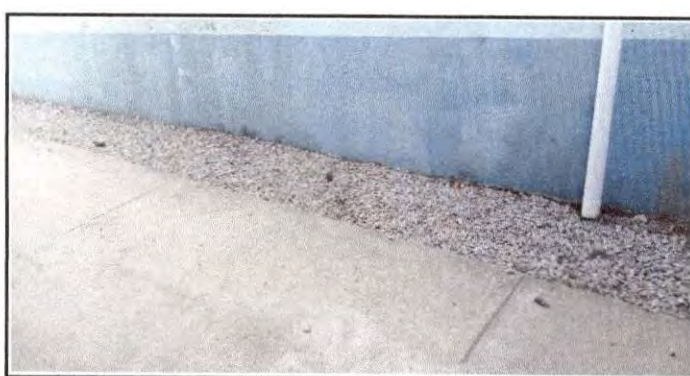
Foto 6: Cuneta de concreto más rejilla de metal
