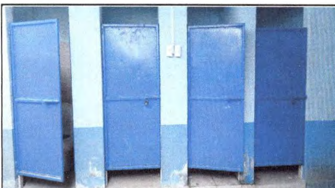
Foto 10 :Sustitución accesorios inodoros (contrallave, tubo abasto)
