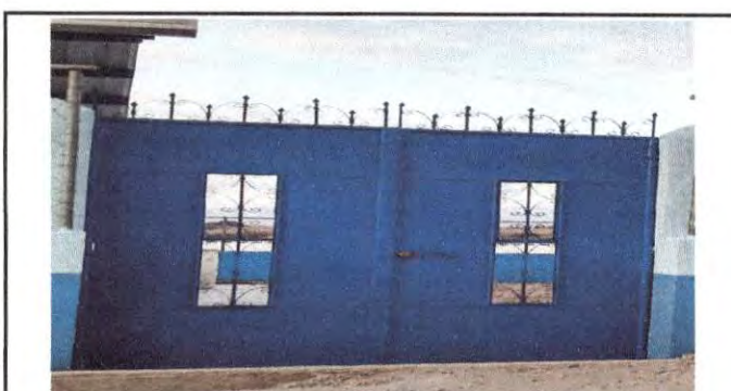
Foto 12: Mantenimiento de portón
