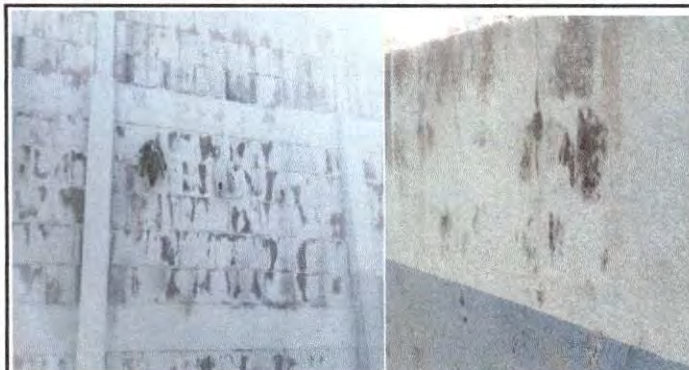
Foto 7: Pintura en muros interiores
