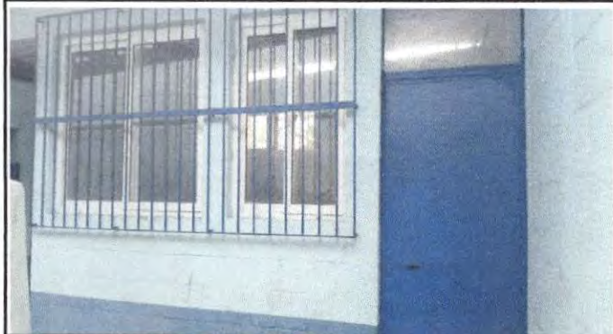
Foto 19: REPARACIÓN DE COCINA
