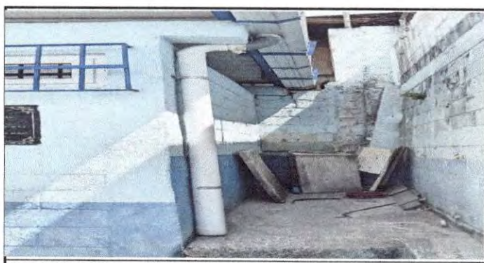
Foto 5: Reparación de canales de agua pluvial
