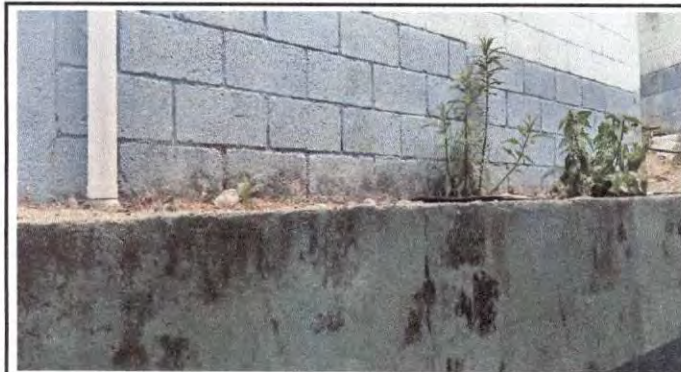
Foto 21: Reparación de muros de contención
