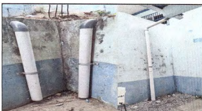
Foto 4: Reparación de canales de agua pluvial
