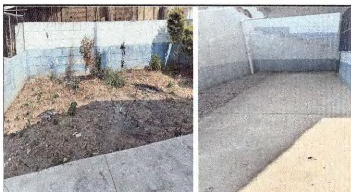
Foto 16: Losa de Patio
