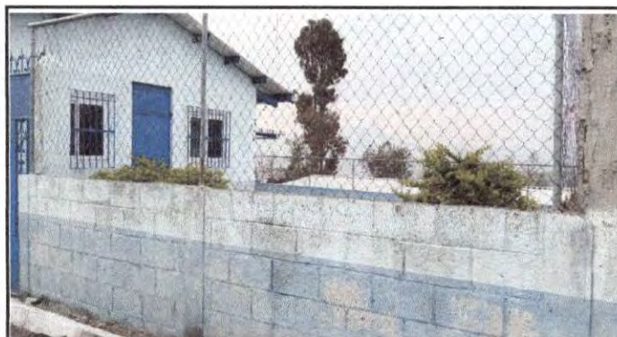
Foto 9 : Pintura en muros exteriores
