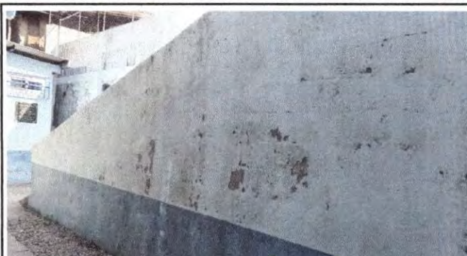
Foto 8: Pintura en muros interiores
