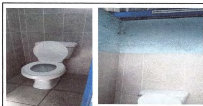
Foto 11: Sustitución accesorios inodoros (contrallave, tubo abasto)
