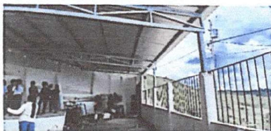
Foto 3: Reparado de losa y patio
