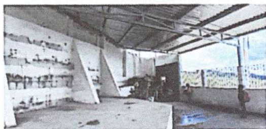
Foto 5: Reparado de losa y patio
