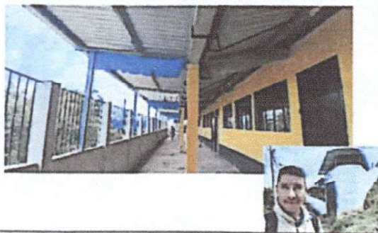
Foto 1: Reparado de Corredor y patio
