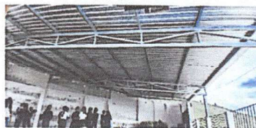
Foto 6: Reparado de losa y patio con cubierta.
