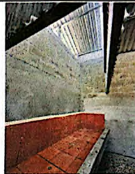
Foto 2: Estufa de leña + conformación de ducto de ventilación.
