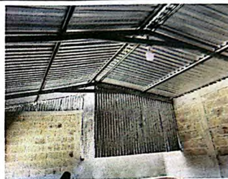
Foto 8: Ducto de ventilación para humo de estufa de leña.
