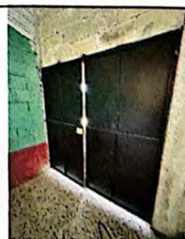
Foto 6: Puerta metálica de acceso secundario a cocina.
