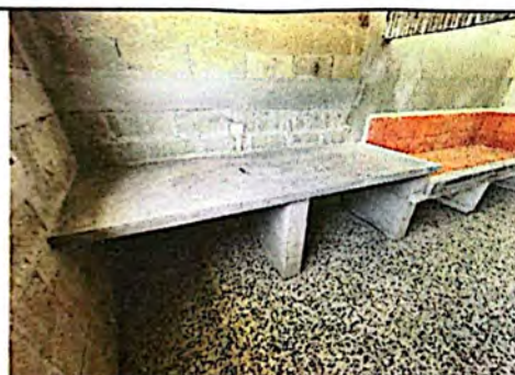
Fabricación de mesa de trabajo con alisado.
