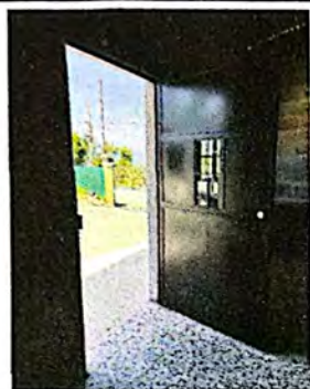
Foto 7: Suministro e instalación de puerta.
