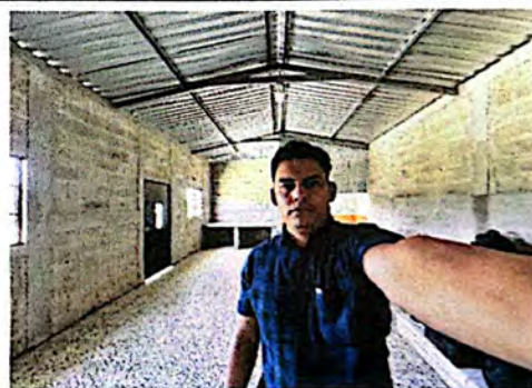
Foto 10: Suministro e instalación de techo con estructura metálica y lámina troquelada.
