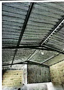
Foto 10: Instalación de techo + chimenea para estufa + iluminación.
