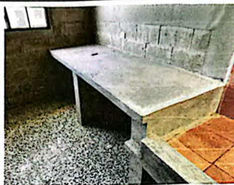
Foto 8: Fabricación de mesa de trabajo con allisado.
