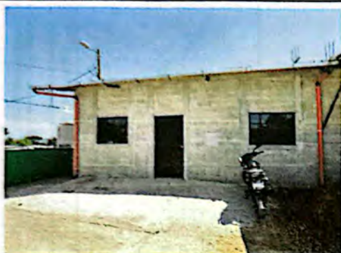
Foto 7: Levantado de muros de mampostería para conformación de cocina.
