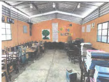
Foto 5: En el Bloque C si se realizaron las juntas de dilatación, pero no se cuenta con piso en los salones de clases.
