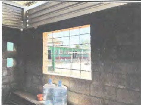
Foto 8: No se cuenta con ventanas en el área de cocina, únicamente cuenta con varillas para la protección del espacio.
