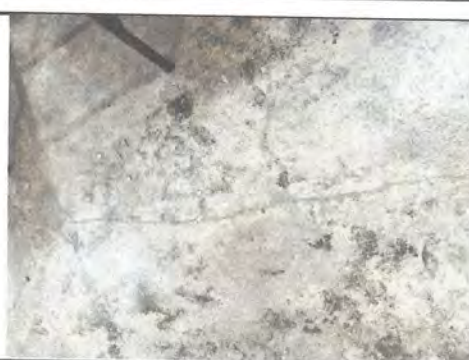
Foto 4: Se aprecian las grietas en el concreto, debido a que no se realizaron los corte al concreto.
