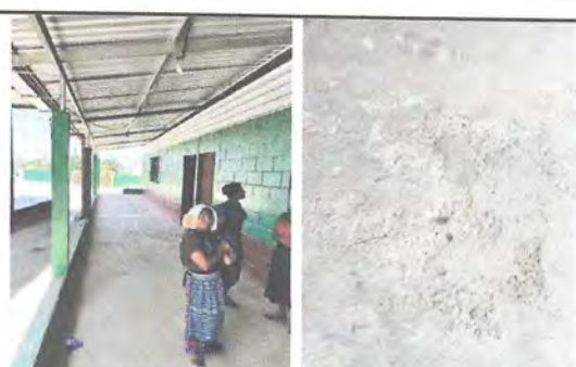
Foto 6: Se puede apreciar el desgaste que ha sufrido el piso de concreto debido al paso de los años.
