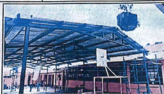
últimos detalles de colocación de lámina.
