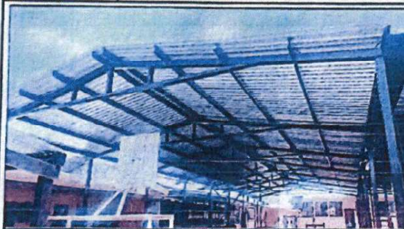
colocación de láminas
