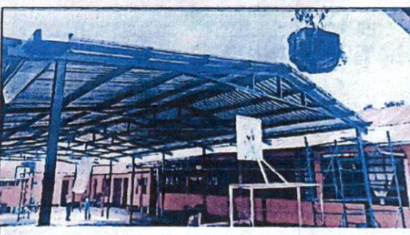
última lamina colocada.
