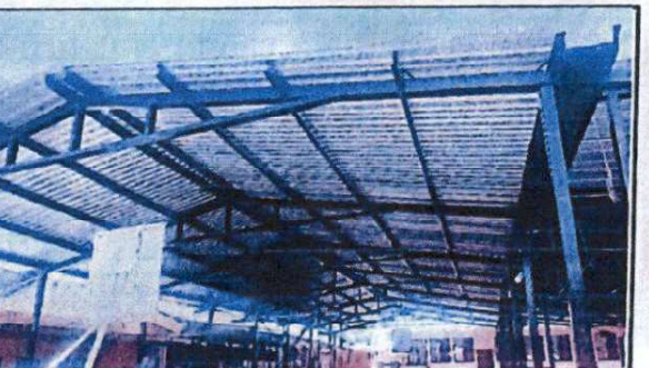
pintura de costaneras
