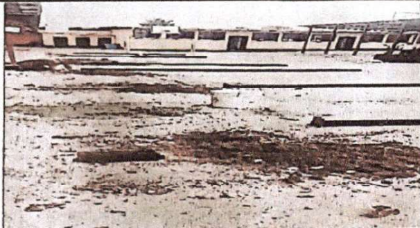
AGUJEROS PARA LOS TUBOS DE 4X4 QUE VAN A SOSTENER EL TECHO.
