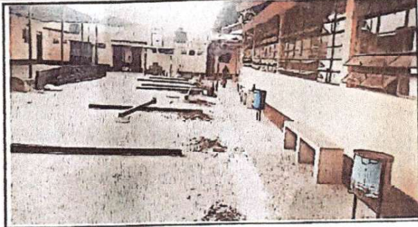
INSTALACIÓN DE TUBOS.
