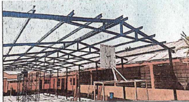
TRABAJO TERMINADO DE INSATALACION DE COSTANERAS
