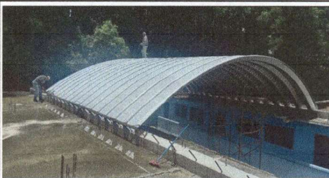
Foto 4: Lámina asegurada en los pines fundidos en la viga.
