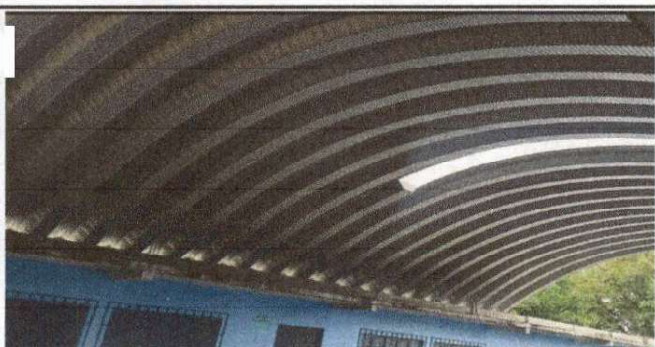
Foto 5: Colocación de tragaluz, para que no que haya claridad en los salones.
