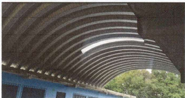
Foto 1: Tejado finalizado con tragaluz primera fase
