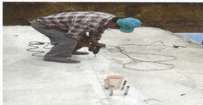
Foto 2: Midiendo la distancia para cada soporte de tensores.
