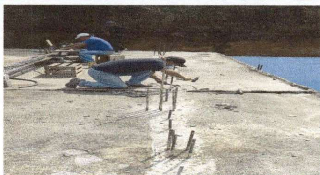
Foto 3: Preparando el área para anclar los soportes a los tensores.
