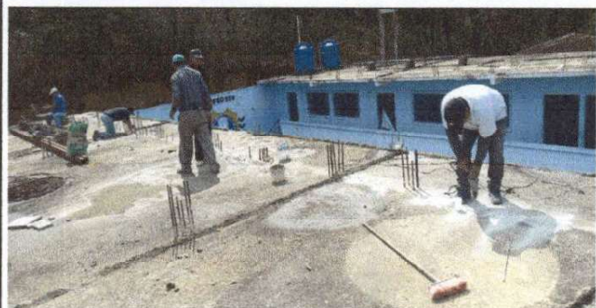
Foto1: Limpiando en área para iniciar a trabajar el techado.
