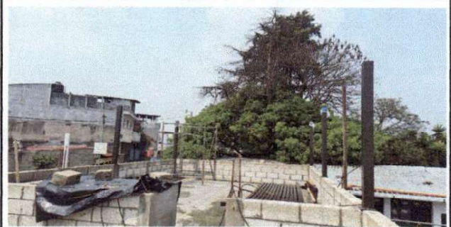
Foto 4: Sustitución de pared de lamina Nivel 3 area de cocina
