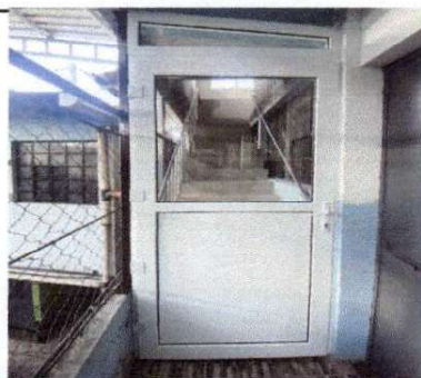
Foto 5: fabricación e instalación de puerta de PVC acceso area de cocina nivel 2
