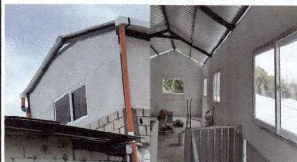
Foto 4: Sustitución de pared de lamina Nivel 3 area de cocina
