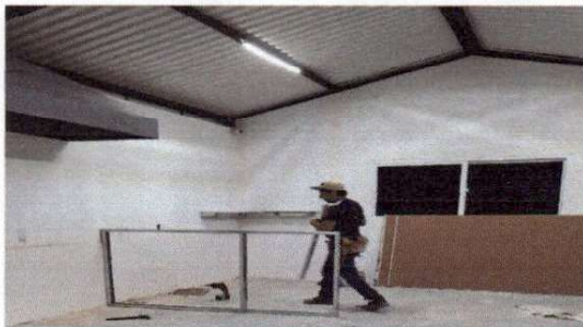
Foto 5: instalación de campana y chimenea de cocina area de cocina nivel 3
