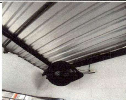
Foto 2: Retiro de cable de energia electrica de salones 2do nivel.
