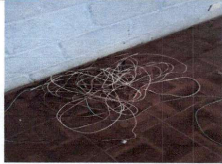
Foto 2: Retiro de cable de energia electrica de salones 2do nivel.
