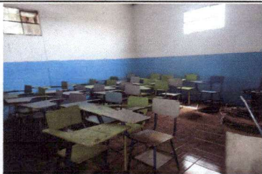
Foto 3: sustitucion de piso granito por piso ceramico Y Pintura de los 4 salones del nivel 2
