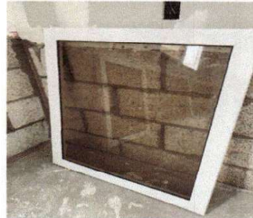
Foto 6: Instalación de ventanas área de cocina, nivel 3
