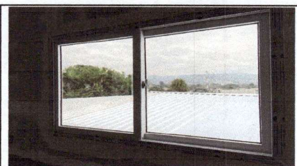
Foto 6: fabricación e Instalación de ventanas área de cocina, nivel 3
