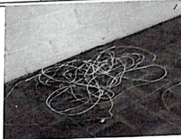
Foto 2: Retiro de cable de energía eléctrica de salones 2do nivel.
