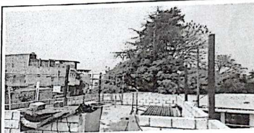
Foto 4: Sustitución de pared de lamina Nivel 3 area de cocina
