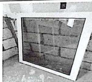
Foto 6: Instalación de ventanas área de cocina, nivel 3
