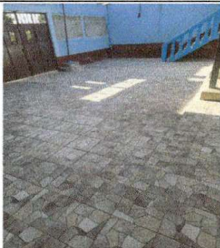
Foto 1: Instalación de piso cerámico en patio principal.
