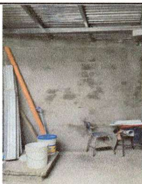
Foto 3: Levantado de muro área de cocina.
