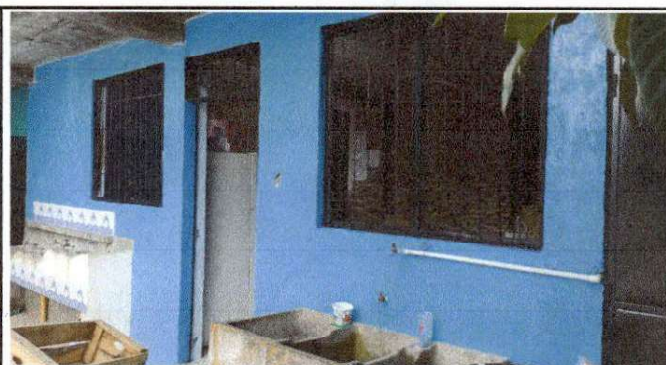
Foto 4: Cambio de ventanas y balcones del área de cocina.
