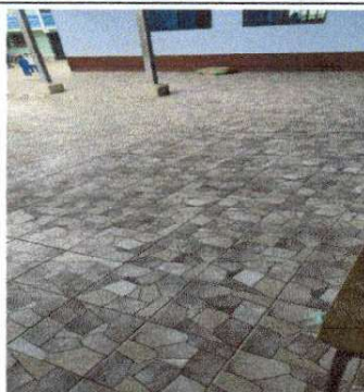
FOTO 2: Instalación de piso cerámico en corredores del área de ingreso.
