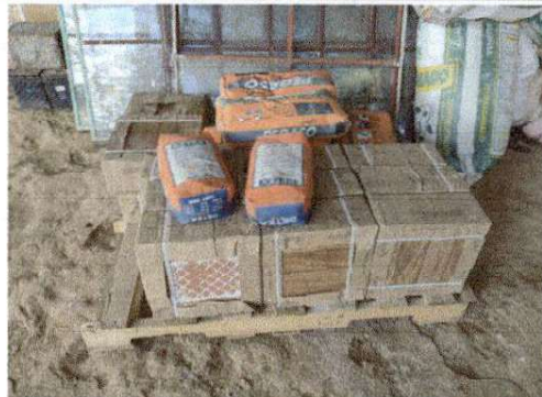
FOTO 2: Instalación de piso cerámico en corredores del área de ingreso.
