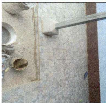
FOTO 1: Instalación de piso cerámico en patio principal.
