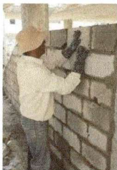
FOTO 3: Levantado de muro área de cocina.
