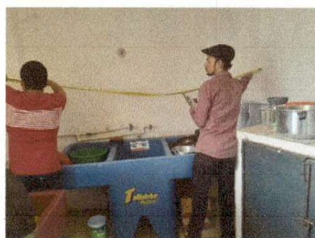
FOTO 4: Cambio de ventanas y balcones del área de cocina.
