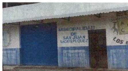
Foto 12: Cubierta de lámina frente al establecimiento (techo voladizo)
