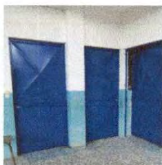
Foto 5: Remozamiento en puertas de metal.
