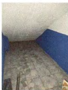
Foto 9: Remozamiento en la bodega del establecimiento
