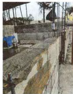
Foto 4: Muro de contención para asegurar la cocina.
