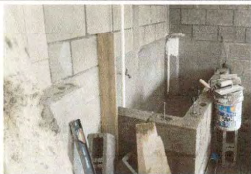
Foto 11: Sustitución de pila en cocina del establecimiento
