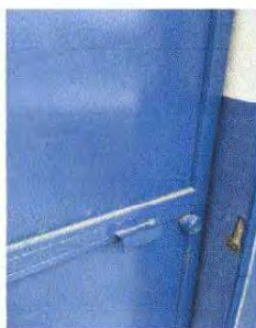
Foto 5: Remozamiento en puertas de metal.
