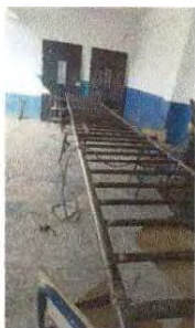
Foto 7: Mantenimiento de baranda, cercana a la cocina
