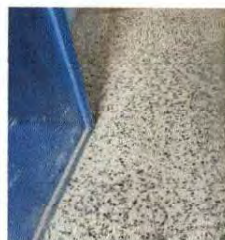
Foto 14: Pintura en puerta de dirección
