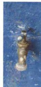
Foto 8: Remozamiento en lavamanos y cambios de grifos
