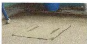
Foto 13: Reparación de tapader de cisterna
