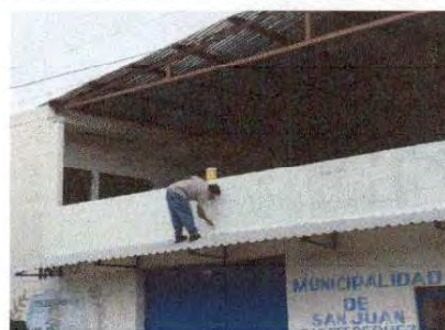
Foto 12: Cubierta de lámina frente al establecimiento (techo voladizo)
