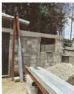
Foto 3: Suministro y mantenimiento de costaneras.
