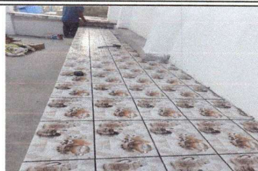
Foto 2: Instalación de azulejo en el área del módulo de la cocina.
