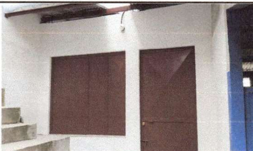
Foto 3: Colocación de la puerta de metal y venta amplia, la cual será el área destinada para el módulo de cocina.
