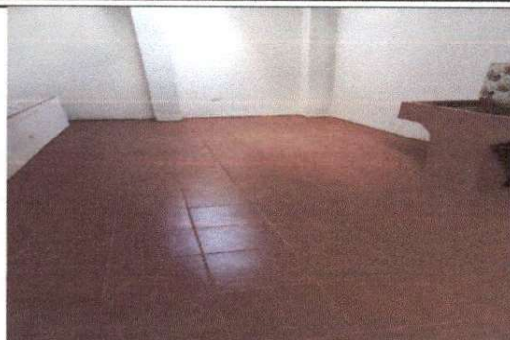
Foto1: finalización del piso cerámico, cernido y colocación de pila.
