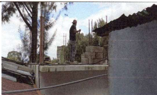
Foto 4: Inicio de construcción del área donde será la bodega, la cual está en la terraza de los sanitarios.
