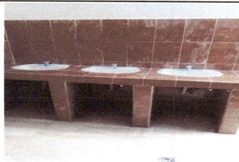
Foto 2: Instalación de azulejo en área de los lavamanos.
