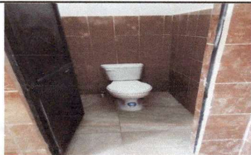
Foto 3: Colocación de azulejo en área de cada sanitario en forma individual, siendo seis baños y al contorno de las dos áreas individuales tanto de niños como para las niñas.
