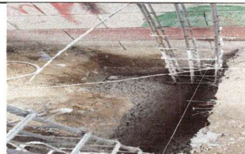
Foto 4: Realización de las columnas respectivas, destinado para el área que será la cocina.
