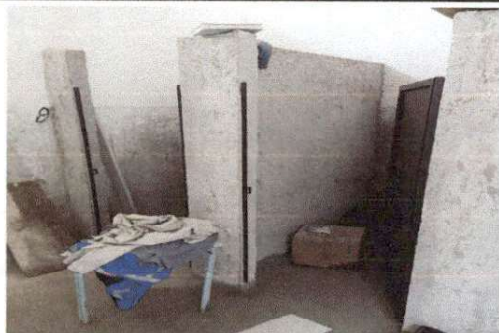
Foto 1: Inicio de repello en área de los sanitarios.
