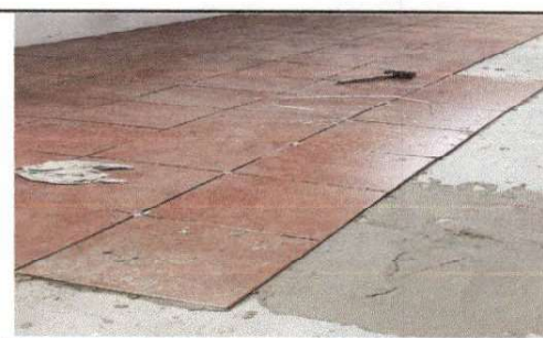
Foto 6: Instalación de cerámico en el área de cocina.
