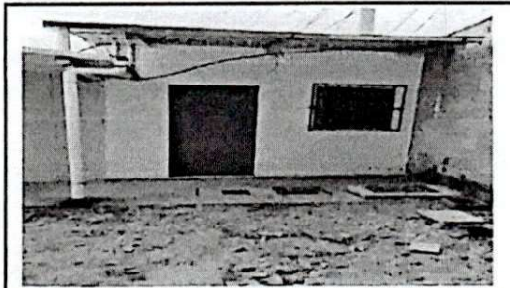
Foto 4: Construcción de aula 4 terminada.
