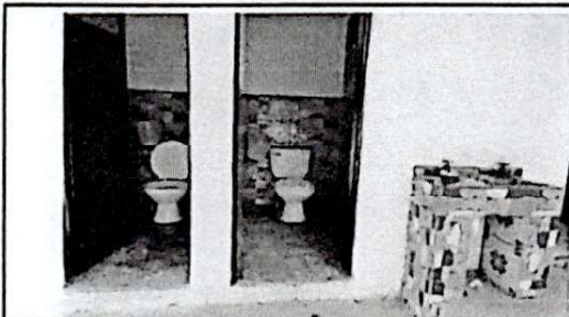
Foto 3: Trabajo terminado de remodelación de sanitarios
