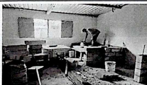
Foto 6: Construcción de piletón en cocina.
