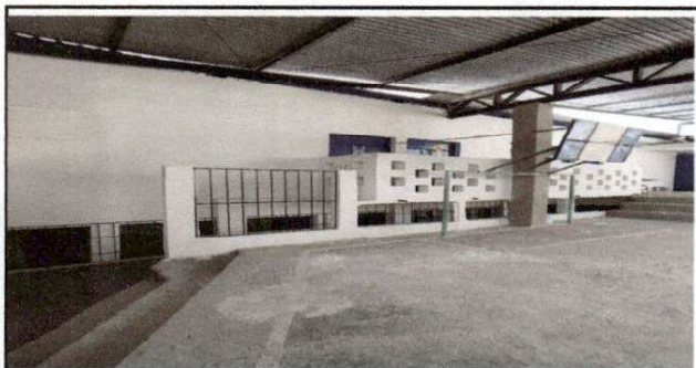
Foto 5: área de la planta alta donde se encuentran 4 aulas a las cuales se les cambio la mayor parte de estructura metalica y cambio de lamina por lamina troquelada
