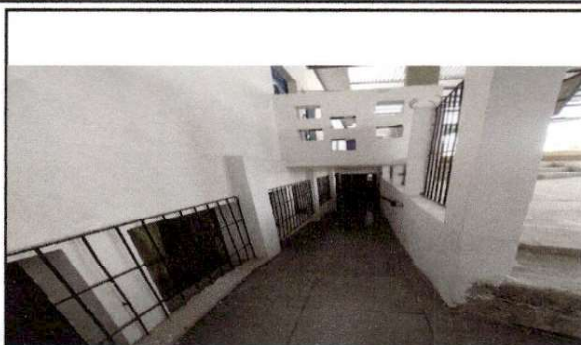
Foto 2: Área de salones parte de la planta alta y baja, cambio de vidrios y reparar ventanas y balcones .
