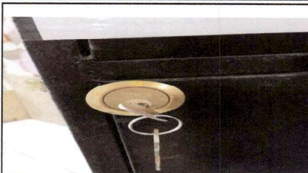
Foto 8: cambio de chapas a dos puertas
