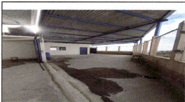
Foto 3: techo para patio para realizar actividades y conecta con la planta alta y baja del establecimiento, cuando llovía no podían los niños bajar al sanitario, se instaló puerta nueva al aula
