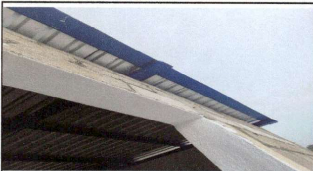
Foto 9: cambio de canales
