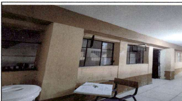
Foto 4: mantenimiento a balcones y cambio de vidrios, en unos casos se modificaron ventanas ya que se encontraban volteadas y no se podían abrir los vidrios, no entraba ventilación
