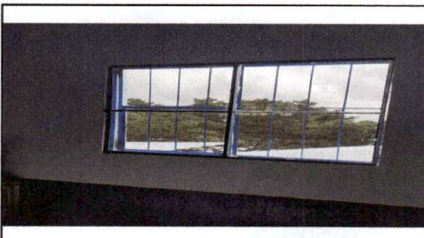
Foto 10: mantenimiento a balcones y cambio de vidrios, en unos casos se modificaron ventanas ya que se encontraban volteadas y no se podian abrir los vidrios, no entraba ventilacion. Se instalaron 6 ventanas nuevas
