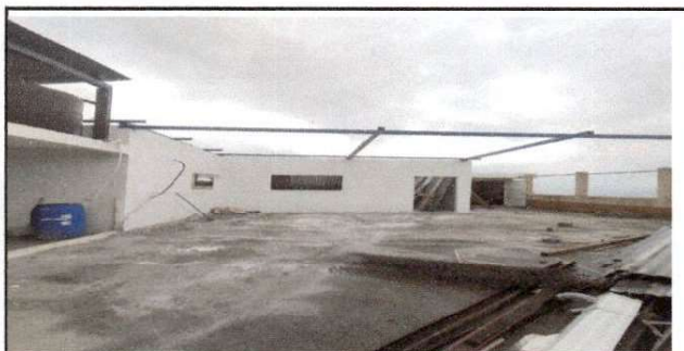
Foto 3: proceso de colocacion de estructura metálica para colocar el techo para patio
