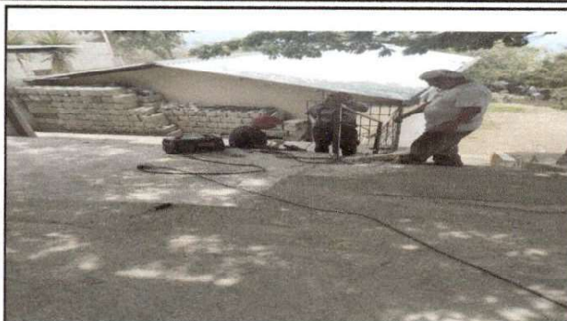
Foto 7: colocacion de barandales
