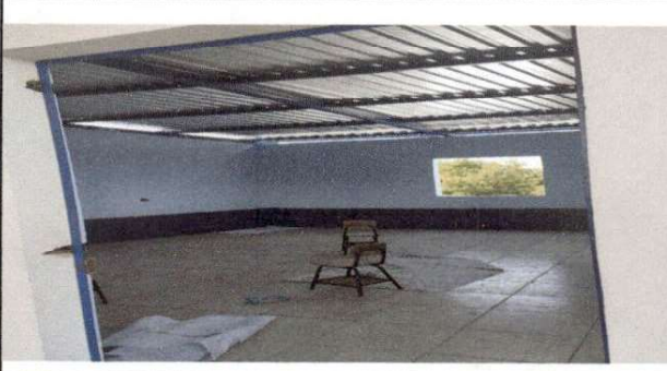
Foto 10: mantenimiento a balcones y cambio de vidrios, en unos casos se modificaron ventanas ya que se encontraban volteadas y no se podian abrir los vidrios, no entraba ventilacion. Se instalaron 6 ventanas nuevas
