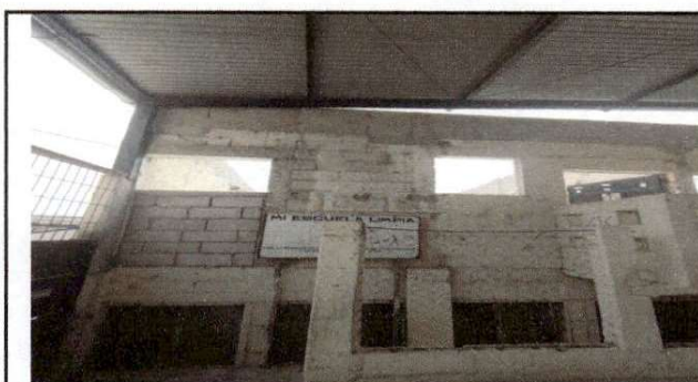
Foto 5: se desmontó la estructura metálica y lámina aulas del segundo nivel
