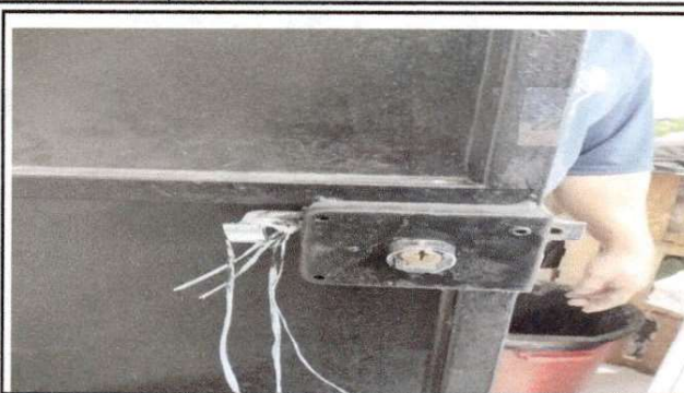
Foto 8: cambio de chapas a dos puertas
