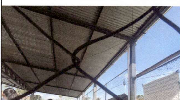
Foto 9: cambio de canales
