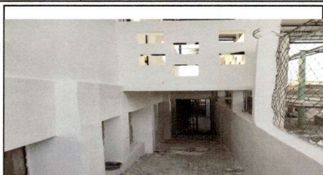
Foto 2: Área de salones parte de la planta alta y baja, se quitaron vidrios y balcones de las ventanas
