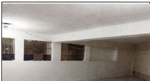
Foto 4: en proceso de mantenimiento a balcones y cambio de vidrios,
