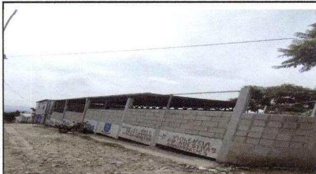
Foto1: Frente y entrada de EODP anexa EORM se modifico el muro perimetral subiendo 5 hilas de block
