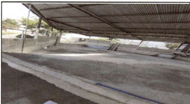
Foto 9: sSe modificó el muro perimetral subiendo 5 hilas de block
