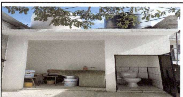
Foto 12: area del lado de cocina se repello y se instalo un sanitario con piso y azulejo para los niños que no pueden bajar las gradas, se instaló otro tinaco .
