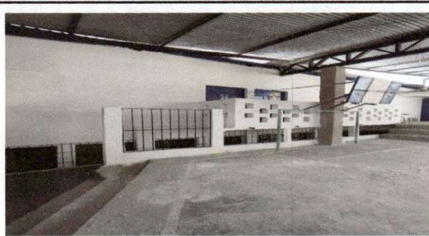
Foto 2: Repello y cernido en las paredes de los salones de la parte alta y repello y cernido dentro de 2 salones
