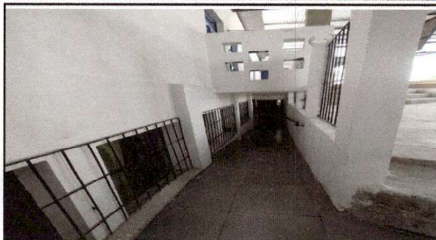
Foto 8: Colocacion de piso en rampa de ingreso, repello y cernido en paredes
