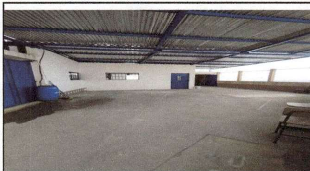
Foto 3: Reparacion del muro en el salon de clases se colocó piso, sustitucion de lámina por block en 2 paredes
