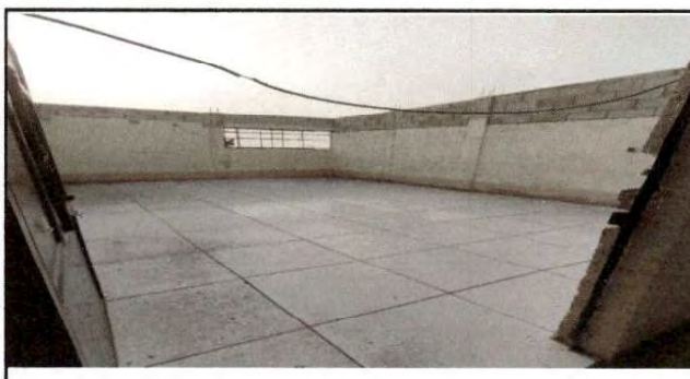
Foto 4: Reparacion de las paredes de 3 salones, se subieron 3 hiladas de block
