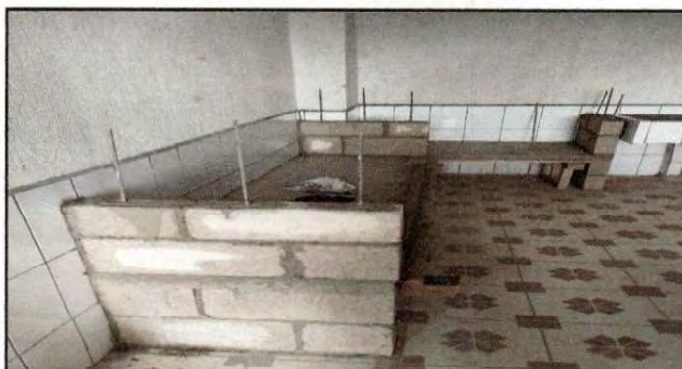
Foto 10: elaboración de mesa de concreto para la cocina
