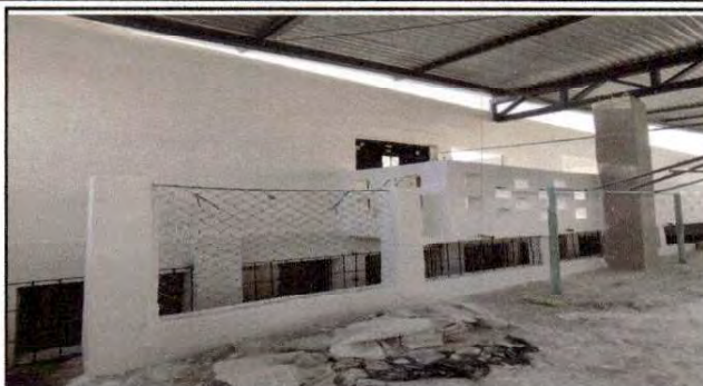
Foto 2: Repellando en las paredes de los salones de la parte alta y repello y cernido dentro de 2 salones
