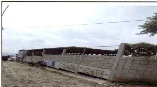
Foto1: Frente y entrada de EODP anexa EORM modificación el muro perimetral subiendo 5 hilas de block
