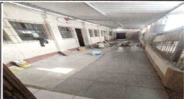
Foto 7: colocación de piso en el corredor de la segunda entrada.
