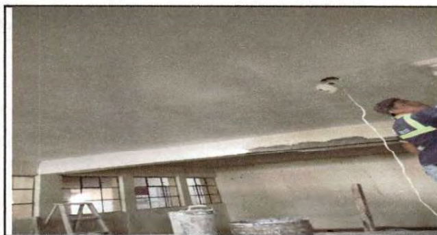
Foto 5: Repello y cernido en el techo de terraza
