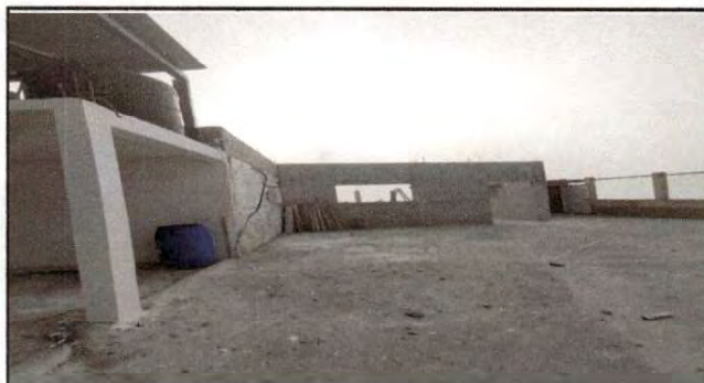
Foto 3: Reparacion del muro en el salon de clases
