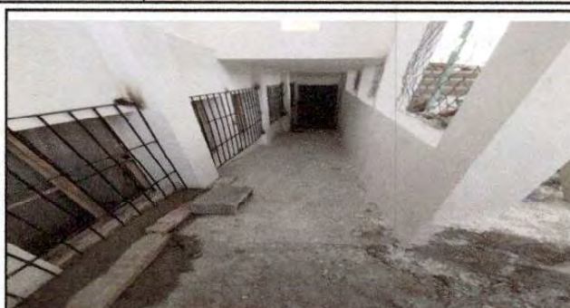
Foto 8: repello y cernido en paredes del area de rampa
