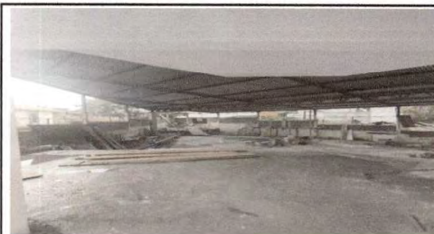
Foto 9: modificación el muro perimetral subiendo 5 hilas de block
