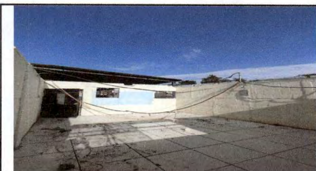
Foto 11: reparar el sistema electrico en los 10 salones
