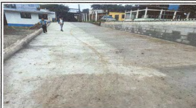
Foto 2: En esta fotografía se observa la rampa y el muro de soporte de la cancha ya finalizado.
