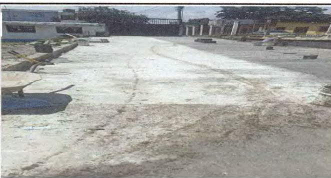
Foto 5: En esta fotografía se observa la rampa ya finalizada.
