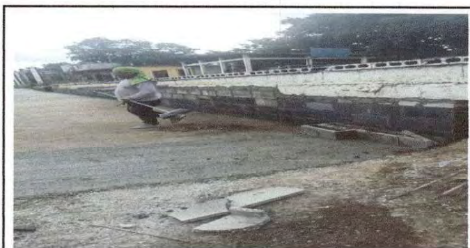
Foto 6: En esta fotografía se observa la rampa ya terminada.
