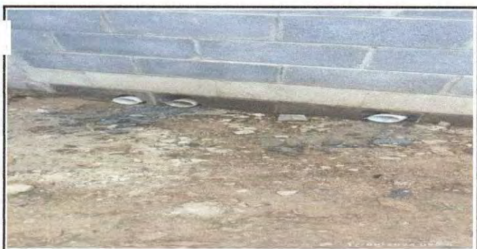
Foto 5: En esta fotografia se observa la pared ya finalizada y as salidas de agua.
