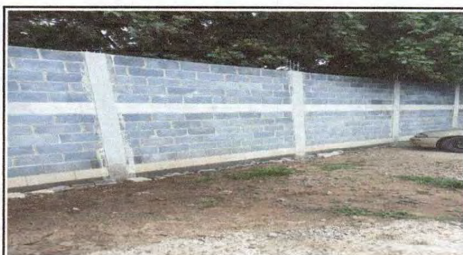
Foto 4: En esta fotografia se observa como quedo la pared.
