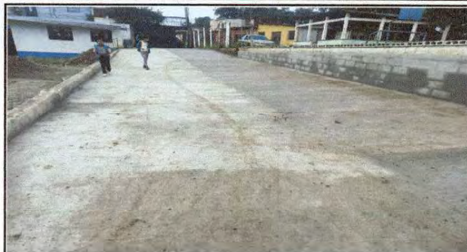
Foto 2: en esta fotografía se observa como quedo la rampa y muro.
