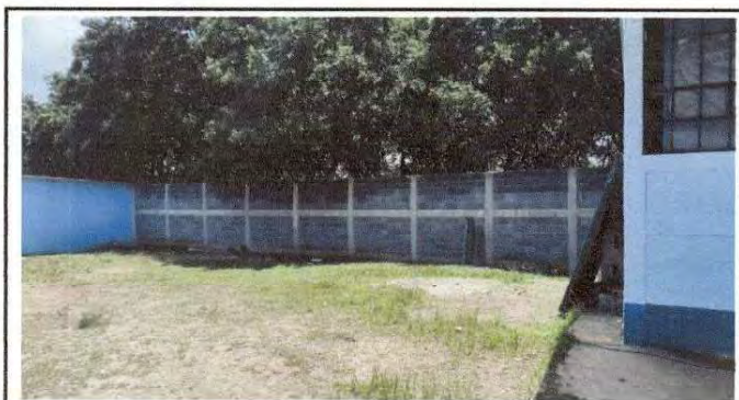
Foto 3: En esta fotografía se observa la pared terminada.
