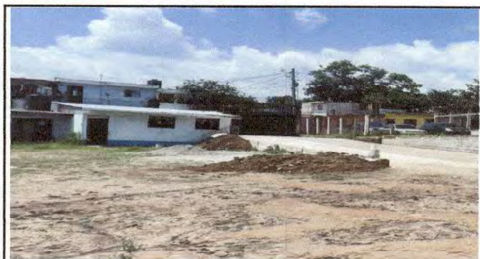
Foto 4: En esta fotografía se observa que el ingreso al establecimiento, es mas accesible al estar pavimentada la rampa.
