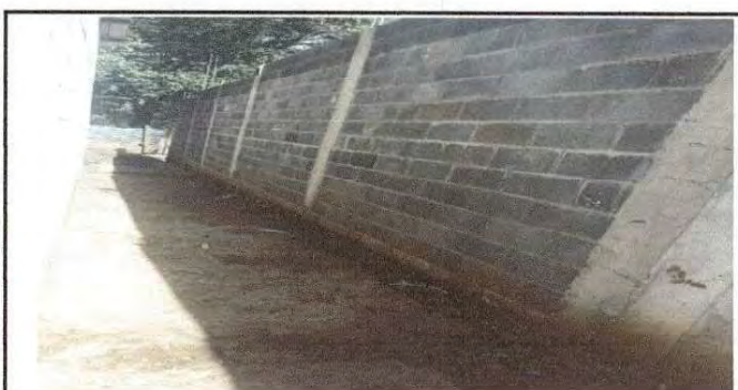
Foto 6: En esta fotografia se observa la pared ya terminada.
