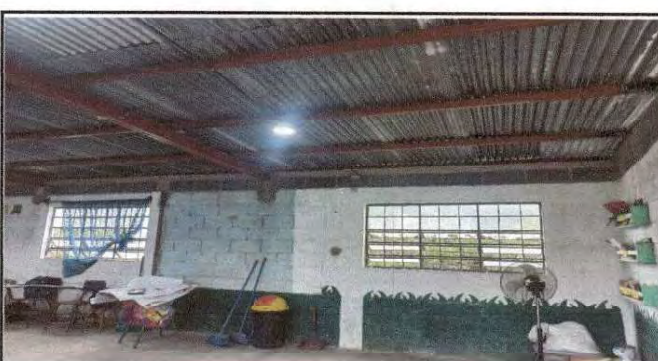
Foto 6: En esta fotografía se observa el levantado del techo, la colocación de estructura metálica y laminado del techo del salón.
