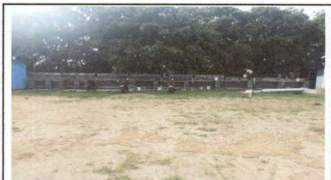
Foto 3: En esta fotografia se observa a los albañiles retirando la madera de las columnas.
