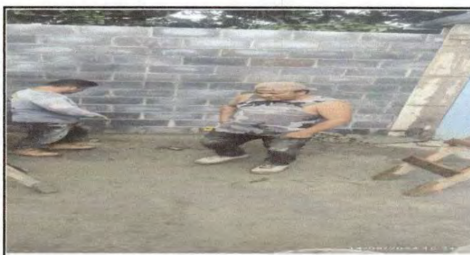
Foto 6: En esta fotografía se observa que ya casi terminan de construir la pared.
