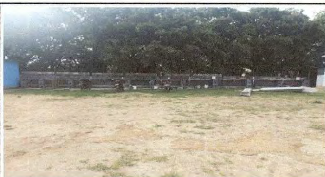
Foto 3: En esta fotografía se observa que ya casi terminan de construir la pared.
