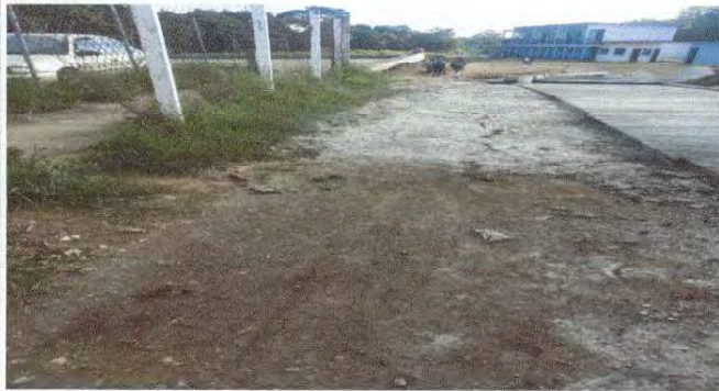
Foto1: En esta fotografia se observa la rampa trabajada en un 50%
