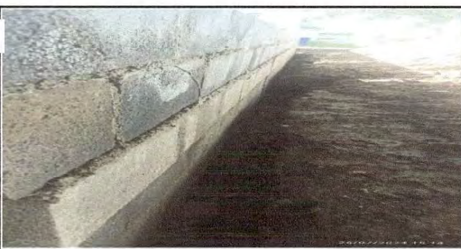
Foto 5: En esta fotografía se observa los cimientos de la pared.
