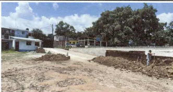
Foto 3: En esta fotografia se observa la que se va avanzando en un 50% el muro que da soporte a las gradas de la cancha.
