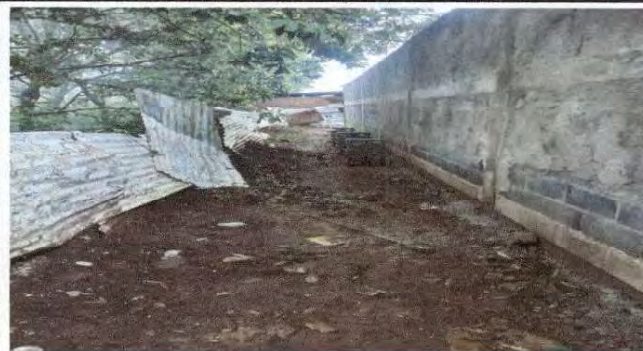
Foto 2: En esta fotografía se observa como va la construcción de la pared.
