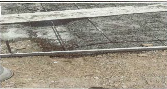
Foto 5: En esta fotografia se observa que la fundicion de la loza de la rampa.
