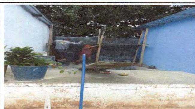
Foto 4: En esta fotografía se observa que ya están casi finalizando la pared.
